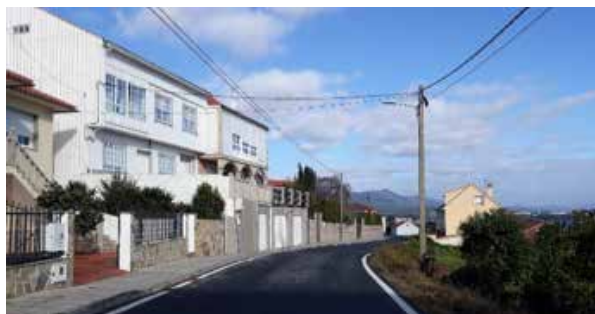
Ribeira (A Coruña). Tramo de doble sentido con señalización horizontal únicamente en los bordes.
